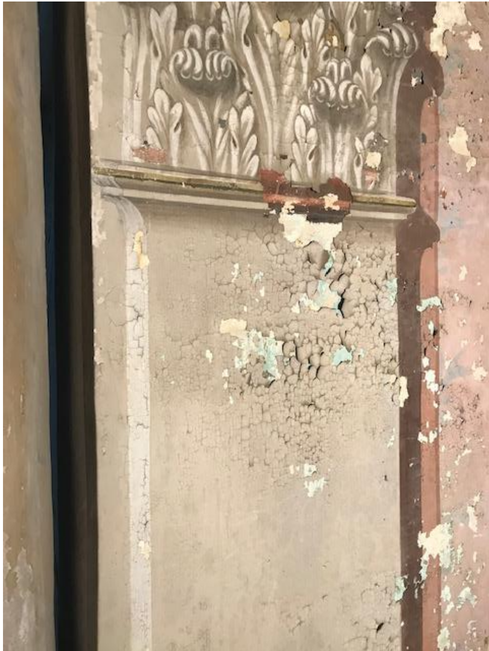
Fixation des écailles de peinture avant reprise des décors peints
