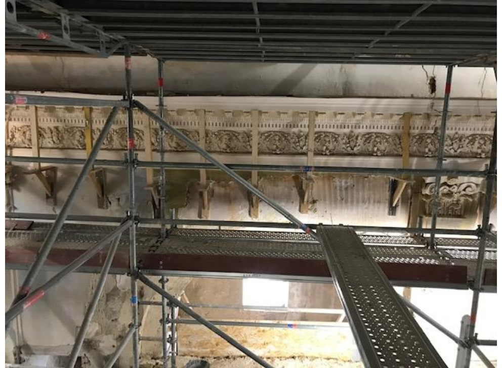
Echafaudage intérieur et étaieage des corniches
