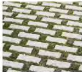
Pavage en béton avec ouvertures de drainage
